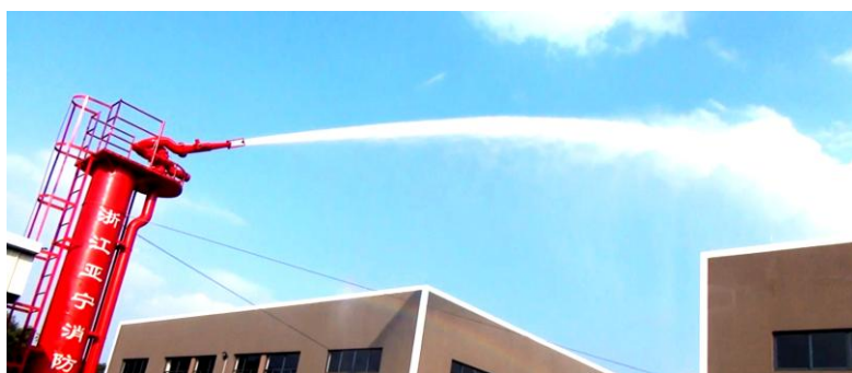
消防炮喷射试验 Fire Monitor Discharge Test
