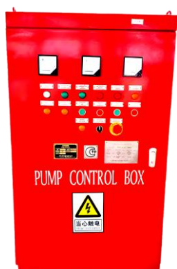
水泵控制箱 Water Pump Control Box
